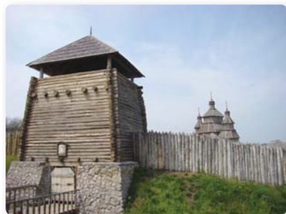
Дерев'яне укріплення — засіка на острові Хортиця
